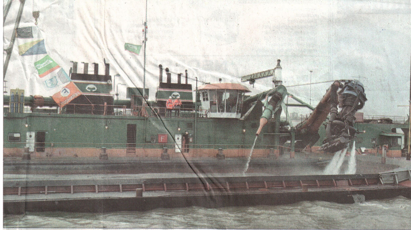
Afgelopen week werd het eerste zand voor de uitbreidingswijk IJburg gestort.
